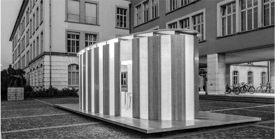
Der elegante, kleine Pavillon beschränkt sich bewusst auf ein extrem reduziertes Materialprogramm. Es wurden nur Schaltafeln (Dreischichtplatten), Platten aus Glasfaserkunststoff und Holzschrauben als Verbindungsmittel eingesetzt.
