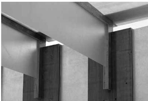
Glasfaserkunststoff lässt sich genau wie Holz bearbeiten, sägen, bohren und schrauben. Beide Materialien lassen sich mühelos mit Akkuschaubern direkt verschrauben. In den leichten Trägern übernimmt das Holz die Druckkräfte, während Zug und Schub vom Glasfaserkunststoff übernommen werden.
