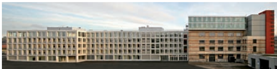
Der Erweiterungsbau des Technoparks (links) bietet 6'000 m 2 Büro- und Laborfläche.
