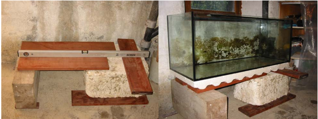
Abb. 2: Das Fundament für ein Aquarium muss stabil, eben und wasserrecht sein. Unmittelbar unter dem Aquarium eignet sich z.B. eine Styroporplatte gut.
