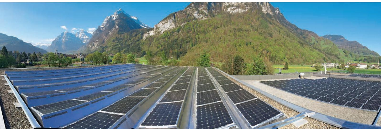
880 Solarmodule mit einer Gesamtfläche von 1400 m<sup>2</sup> erzeugen Sonnenstrom für etwa 80 Haushalte. 180 dieser Module sind sogenannte Hybridkollektoren. Der Aufbau entspricht
