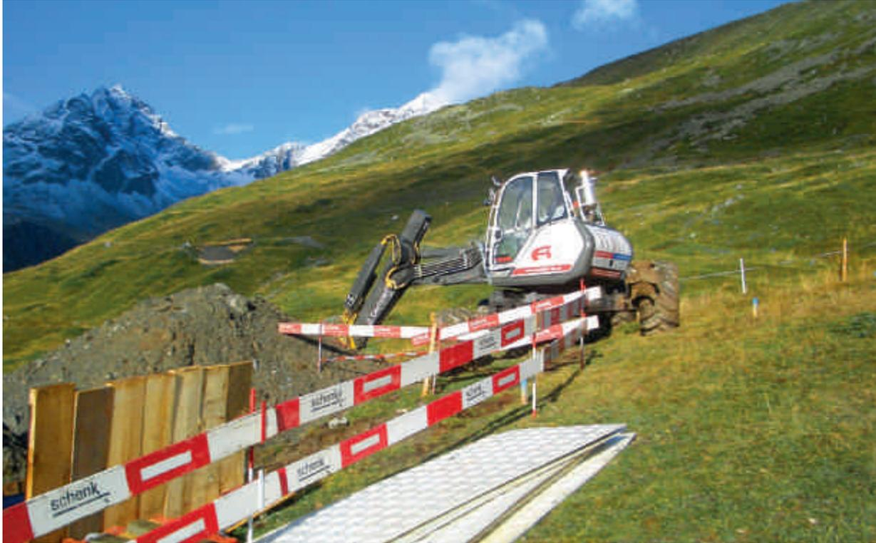
Statt eines Grabens quer durch das Moor nur zwei Löcher: Leitungsbau im Bohrverfahren.
