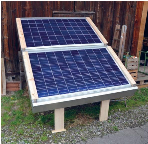
Prototyp einer Holzunterkonstruktion für ein Aufdach-System.
