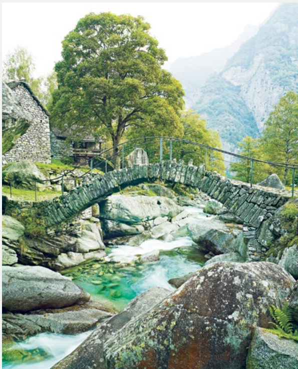
Brücke Puntid bei Foroglio, Val Calnegia, Tessin (Bild: Michael Rast, Stiftung Umwelt-Einsatz Schweiz)
