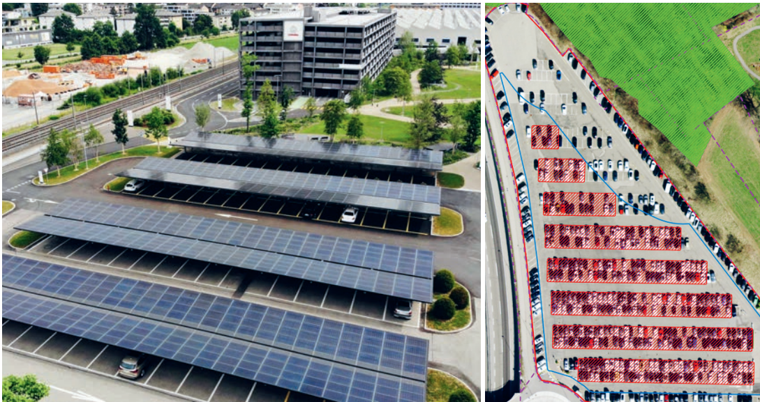
Visualisierung eines PV-Carports (links). Ausschnitt aus der GIS-Analyse (rechts). Die nutzbare Fläche wurde berechnet (blaue Linie). Die spezielle Form ergibt sich aufgrund der baurechtlichen Vorschriften, die einen Waldabstand von 30 m fordern. Darin wurden PV-Carports platziert (rot).
