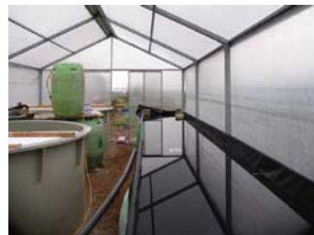
Slika 6: Gradnja rastlinjaka v Biotehniškem centru Naklo in priprava rastlinske grede ter bazenov za ribe.
