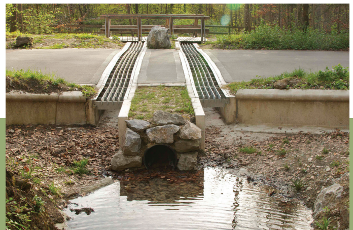
Fig. 2: Les franchissements de part et d'autre de la canalisation du ruisseau et les éléments de guidage de chaque côté (photo: Grün Stadt Zürich).
