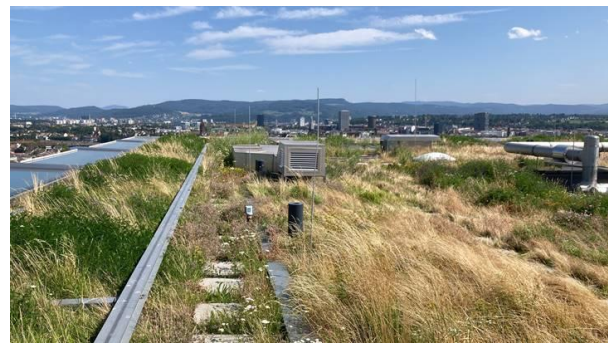
Abb. 2 Dachbegrünung Biozentrum am 07.07.2023, bewässert. (J. van Gogh)
