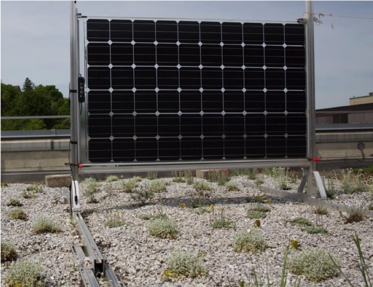
Abbildung 3: System 3 (in Entwicklung) senkrecht aufgeständertes Bi-faciales Photovoltaik Modul („PV & Dachbegrünung | VESE“, 2015).
