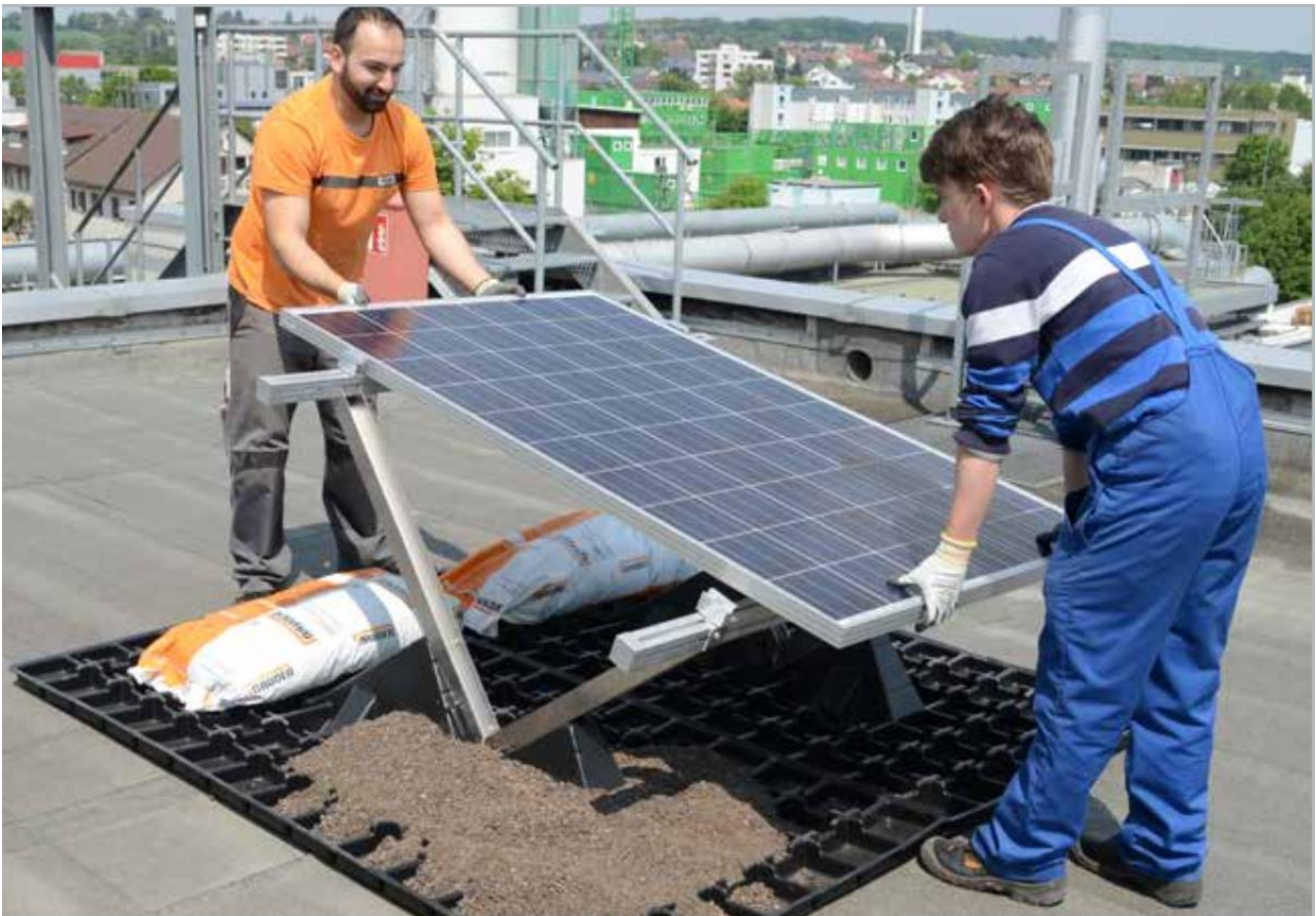
Abbildung 1: System 1 von BauderSOLAR, der Fuss wird mit Substrat beschwert (Bauder, 2017).
