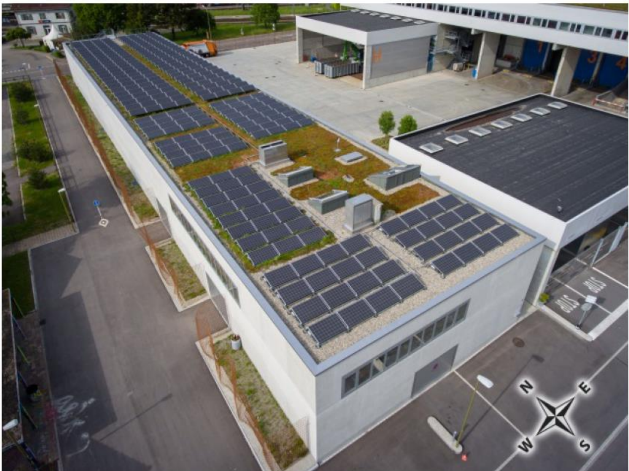
Abbildung 4: Versuchsanlage der ZHAW in Winterthur mit einer Leistung von 72kWp (Baumann et al., 2016)
