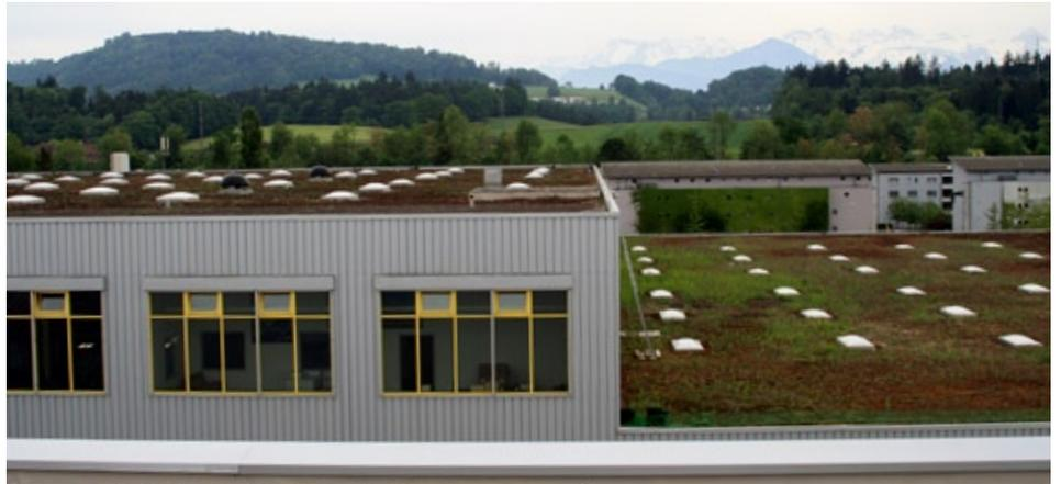
Auf diesem Bild sind die beiden Dächer – im Text als oberes und unteres Dach beschrieben – gut ersichtlich. Erkennbar sind auf dem unteren Dach die Vegetationsbereiche (grün), die durch den Schattenwurf des oberen Daches und des dadurch länger anstehenden Wassers sich besser entwickeln, als auf dem oberen Dach.
